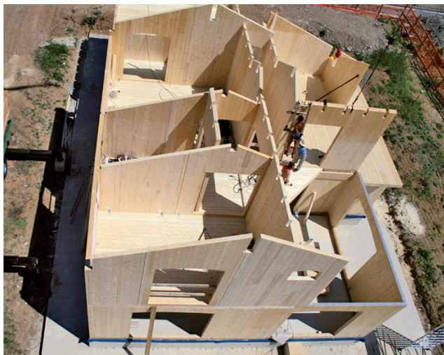
Figura 1 - Esempio di costruzione in X-LAM
